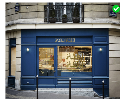
Devantures respectant les alignements de façade (en applique et en feuillure).
