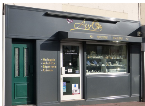
✗ Menuiseries extérieures disparates
